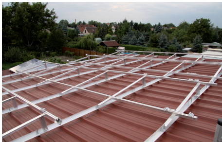
Abb. 16: Durch das Montagegestell sind die Module fest mit dem darunter liegenden Dach verbunden. Die eingesetzten Verbindungstechniken können nicht ohne weiteres entfernt werden, damit sie Schnee und Sturm standhalten. Die Befestigung stellt auch einen wichtigen Teil des Diebstahlschutzes dar.
